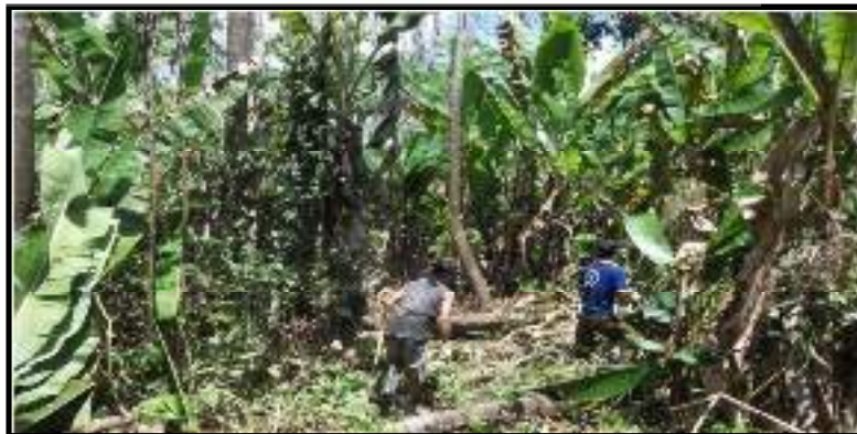
Gambar 4.4 Pembukaan Jalan ke Lokasi Pengeboran
